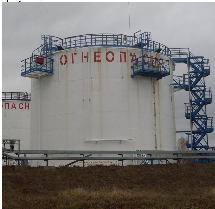
Рисунок 1 – Общий вид резервуара стального вертикального цилиндрического РВС-2000
