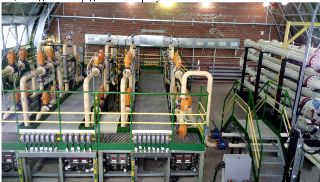
Рисунок 1 – Общий вид СИКН
