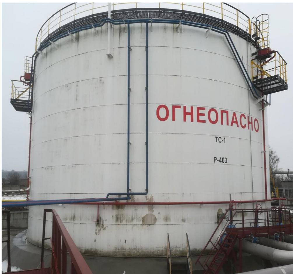
Рисунок 1 – Общий вид резервуара стального вертикального цилиндрического PVC-5000
