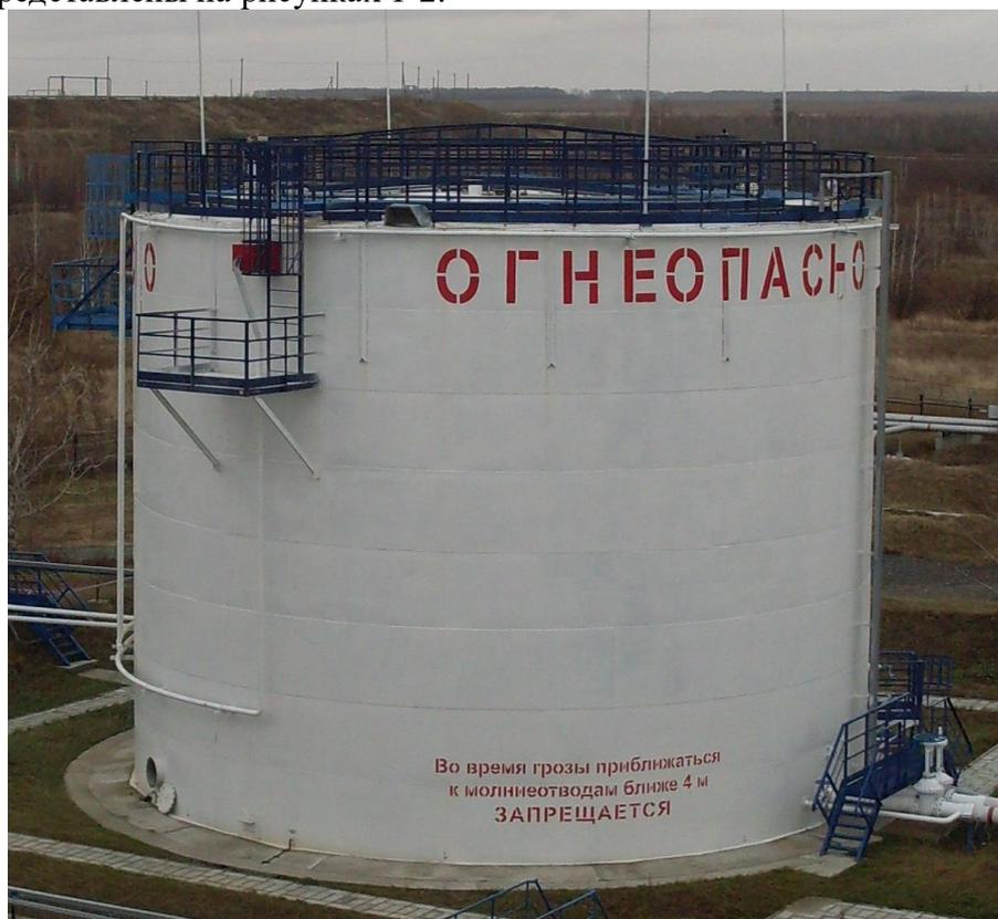
Рисунок 1 – Общий вид резервуара стального вертикального цилиндрического РВС-2000
