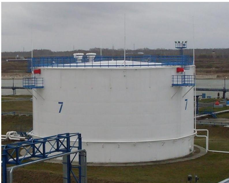
Рисунок 2 – Общий вид резервуара стального вертикального цилиндрического РВС-5000
