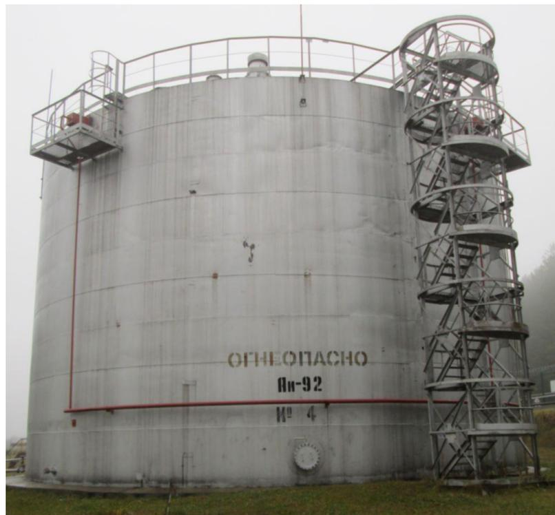
Рисунок 3 – Общий вид резервуаров стальных вертикальных цилиндрических РВС-3000
