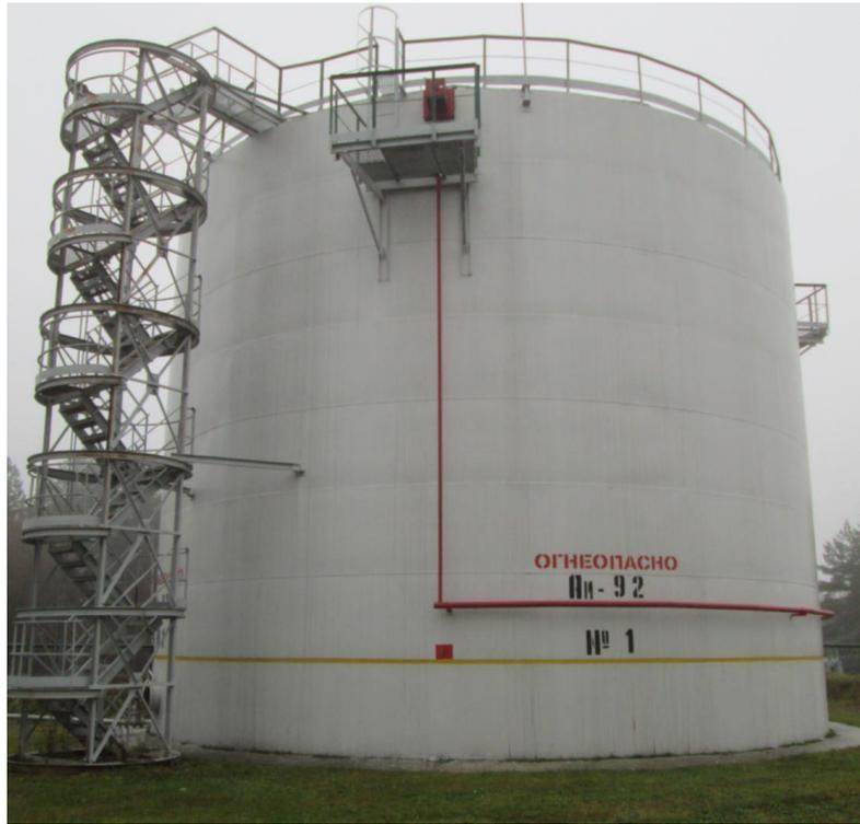
Рисунок 2 – Общий вид резервуаров стальных вертикальных цилиндрических РВС-2000
