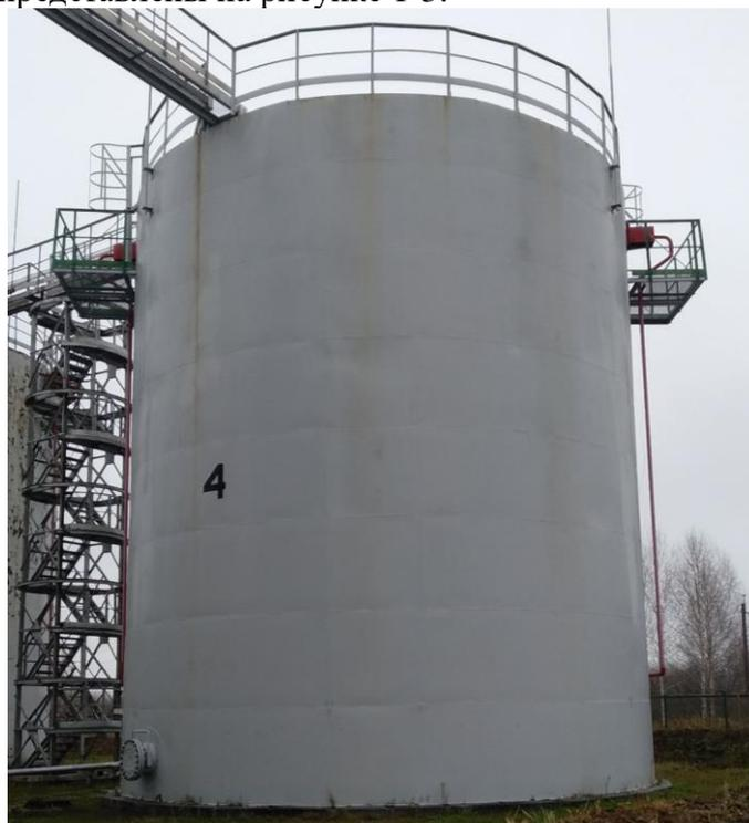
Рисунок 1 – Общий вид резервуаров стальных вертикальных цилиндрических РВС-1000
