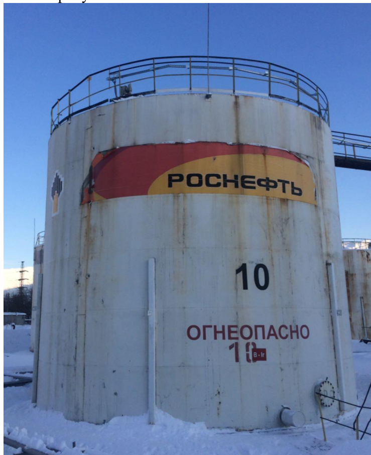
Рисунок 1 – Общий вид резервуаров стальных вертикальных цилиндрических РВС-700
