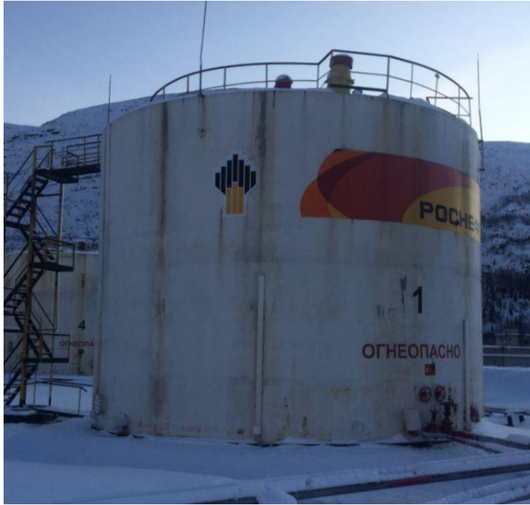
Рисунок 2 – Общий вид резервуаров стальных вертикальных цилиндрических РВС-1000
