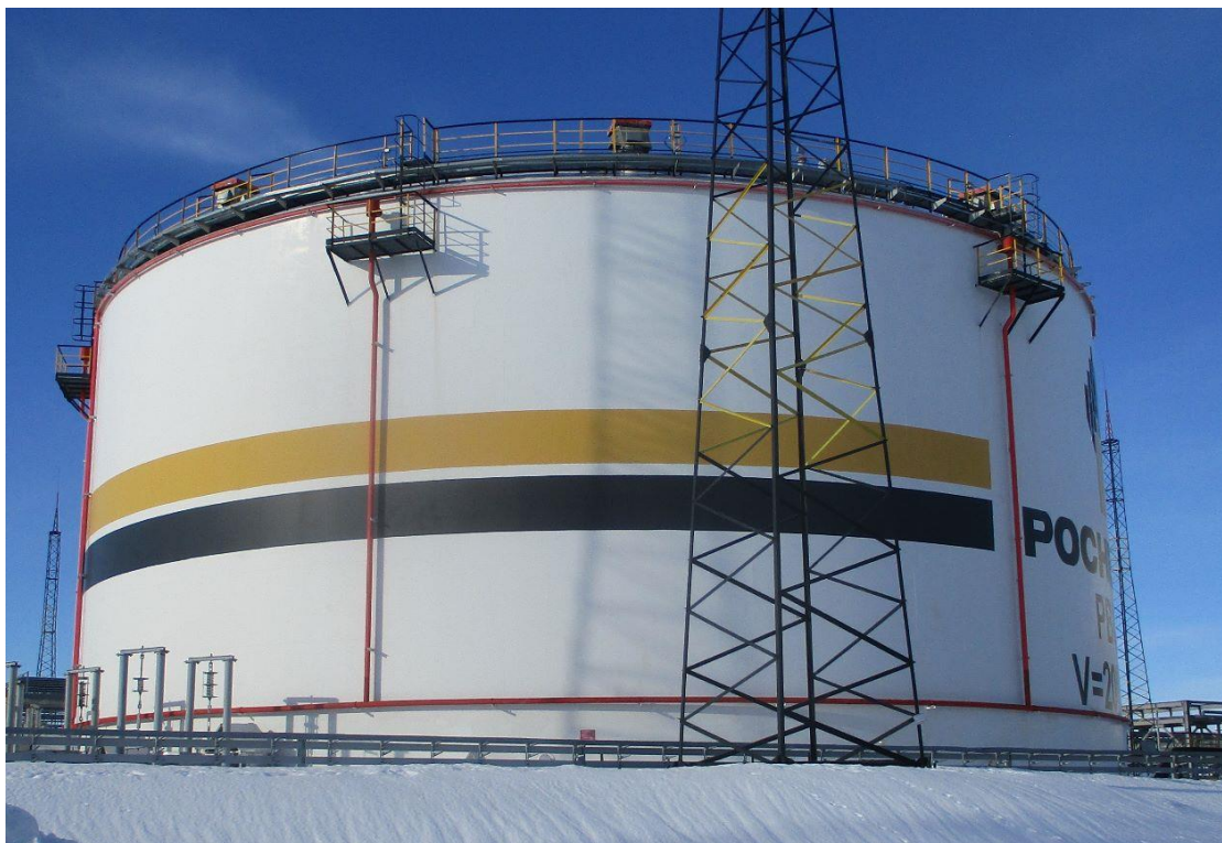
Рисунок 1 – Общий вид резервуаров стальных вертикальных цилиндрических РВС-20000
