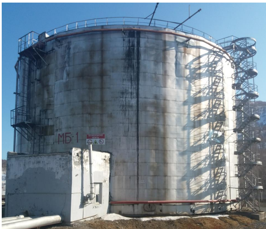
Рисунок 1 – Общий вид резервуара РВС-10000
