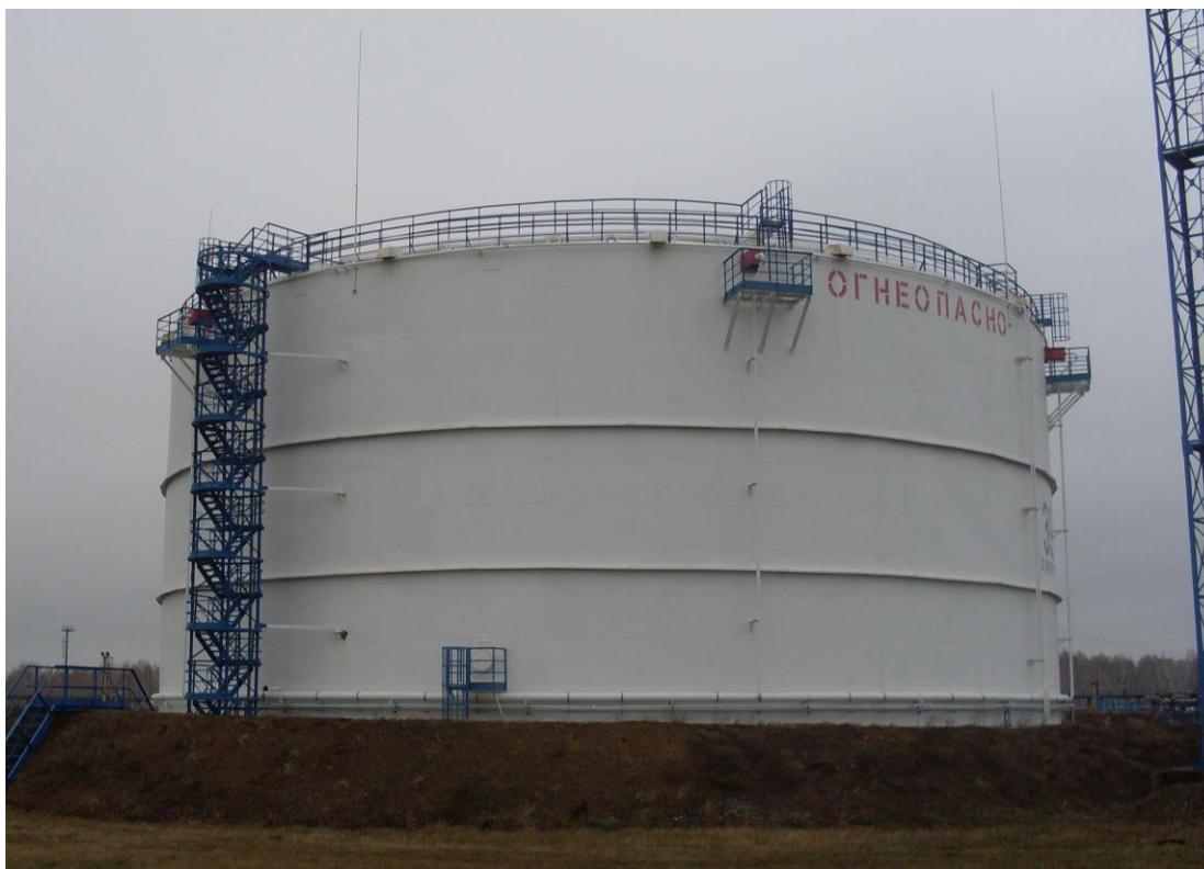
Рисунок 1 – Общий вид резервуаров стальных вертикальных цилиндрических РВС-20000
