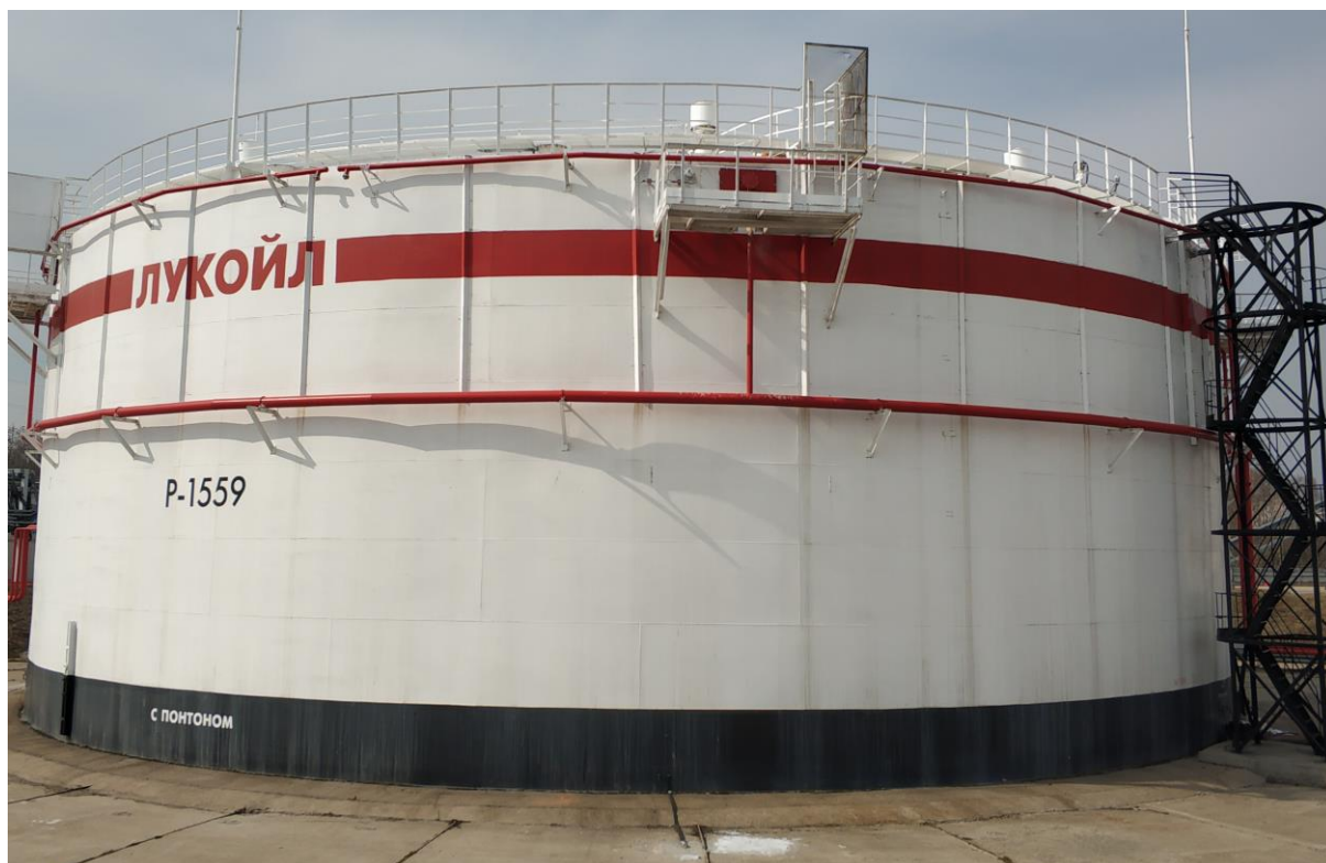
Рисунок 1 – Общий вид резервуара РВСП-10000
