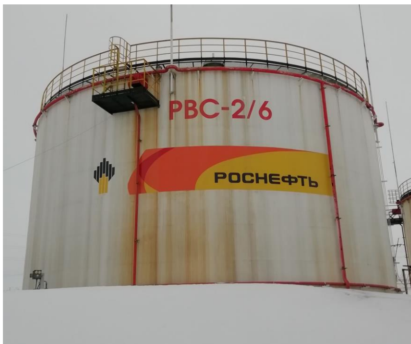
Рисунок 3 – Общий вид резервуаров стальных вертикальных цилиндрических РВС-4000
