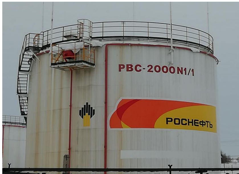
Рисунок 2 – Общий вид резервуаров стальных вертикальных цилиндрических РВС-2000
