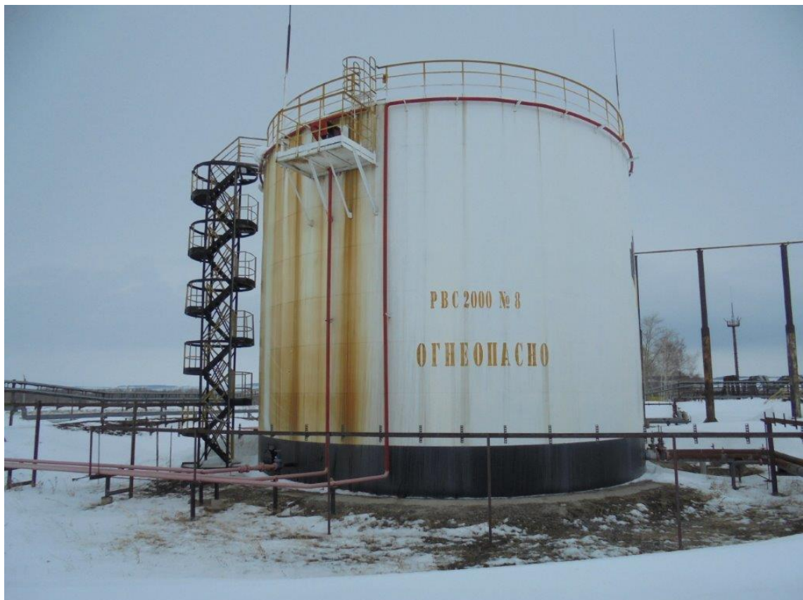
Рисунок 1 – Общий вид резервуаров стальных вертикальных цилиндрических РВС-2000
