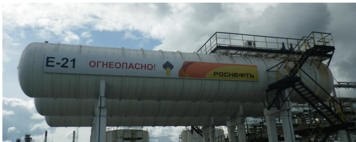
Рисунок 1 – Общий вид резервуара стального горизонтального цилиндрического РГС-200
