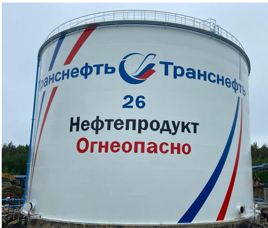
Рисунок 1 – Общий вид резервуара РВС-10000
