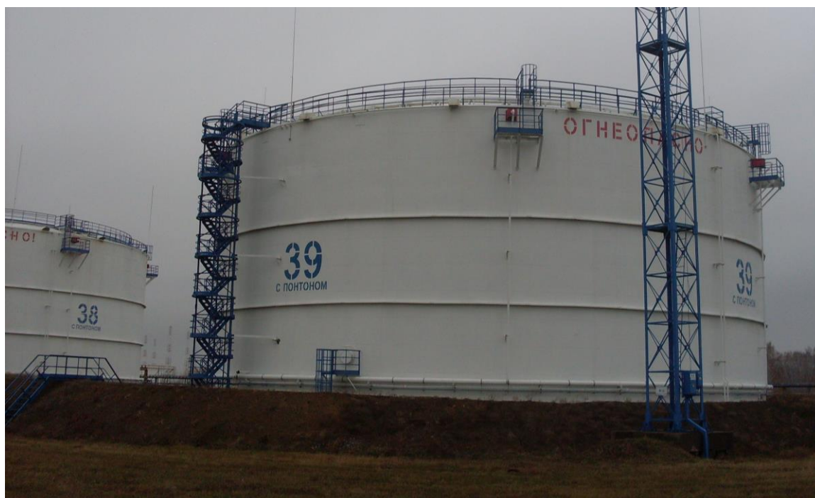
Рисунок 1 – Общий вид резервуаров стальных вертикальных цилиндрических с понтоном РВСП-20000
