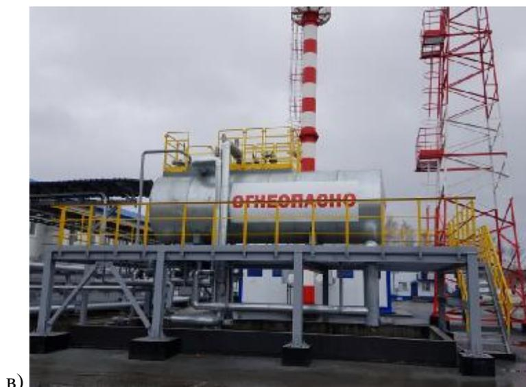
Рисунок 1 – Общий вид резервуаров стальных горизонтальных цилиндрических РГС-20 (17+3)
