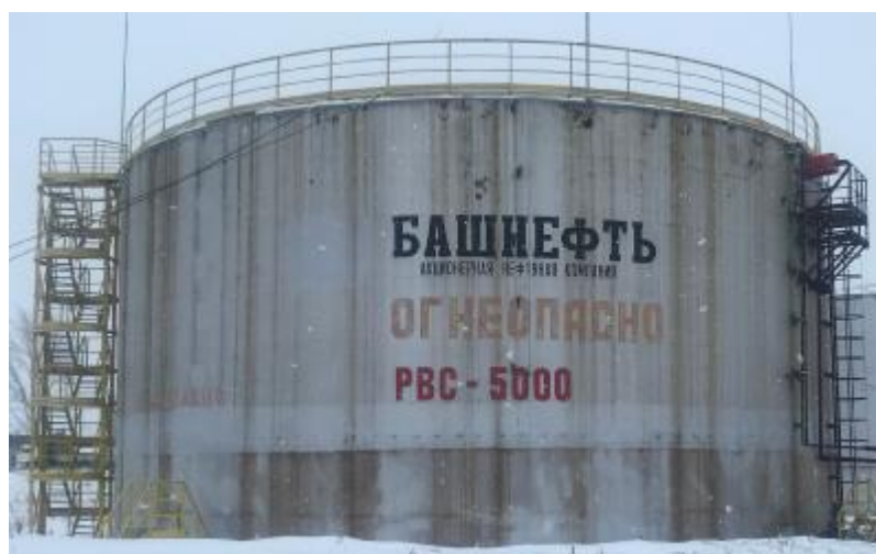
Рисунок 3 – Общий вид резервуаров стальных вертикальных цилиндрических РВС-5000
