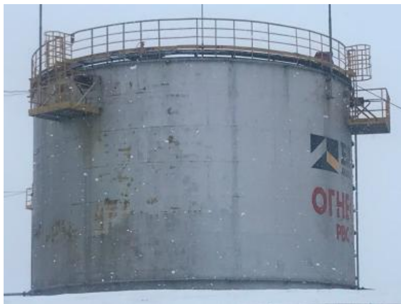
Рисунок 2 – Общий вид резервуаров стальных вертикальных цилиндрических РВС-2000
