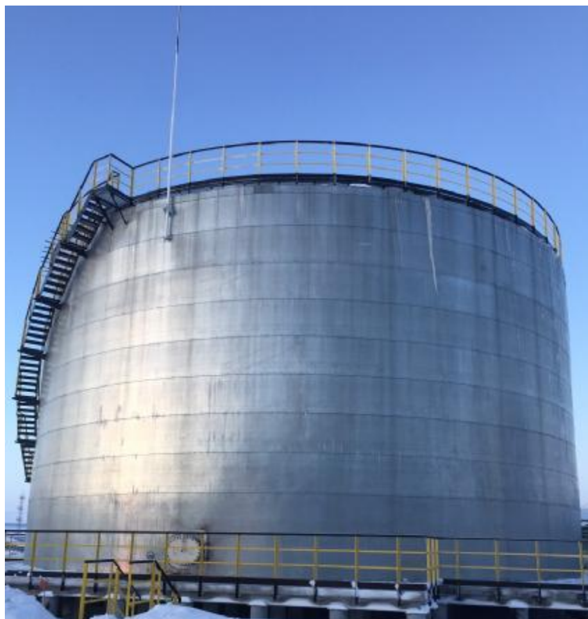
Рисунок 2 – Общий вид резервуара стального вертикального цилиндрического РВС-5000
