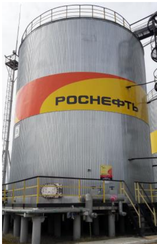
Рисунок 1 – Общий вид резервуара стального вертикального цилиндрического РВС-1000
