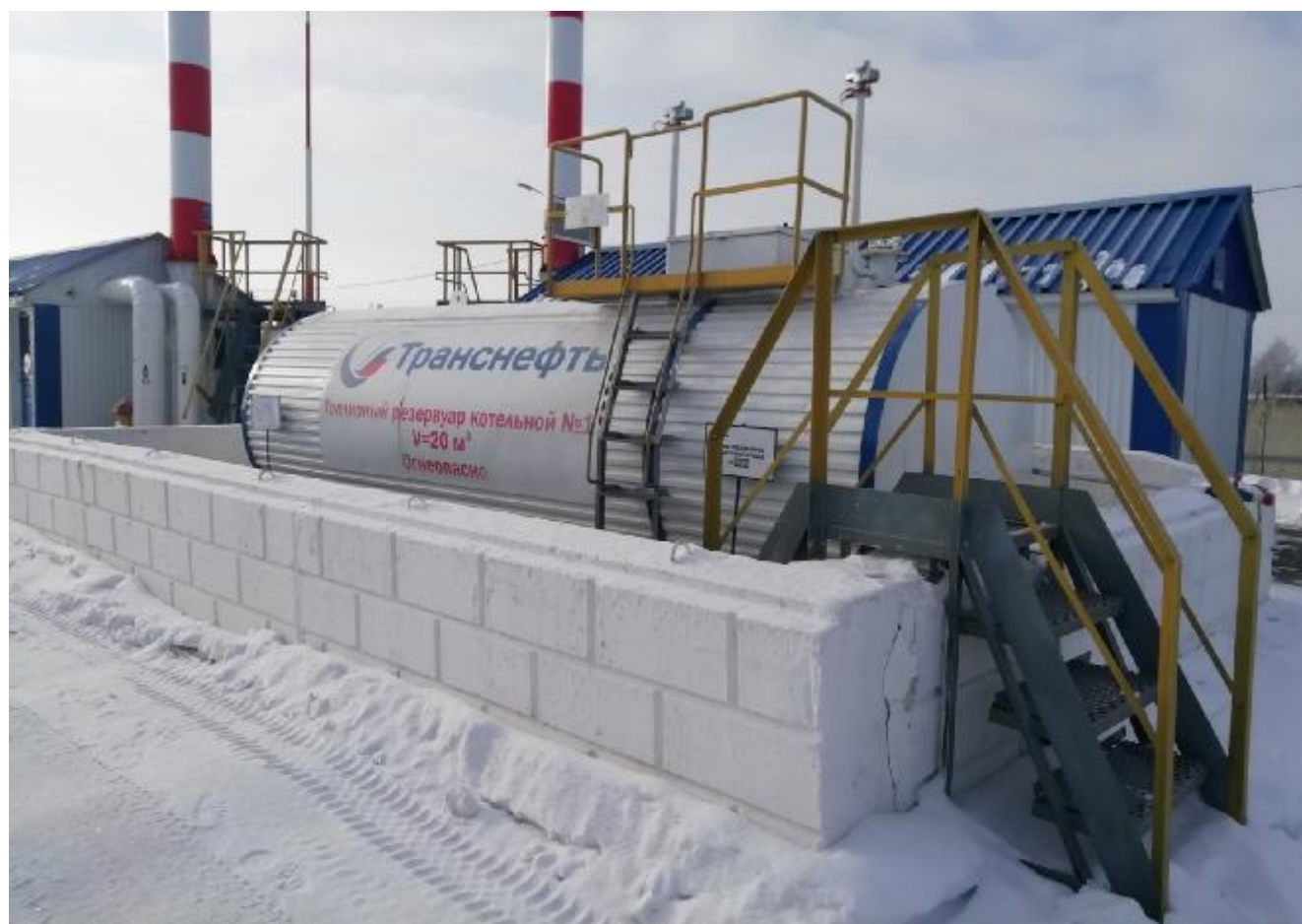
Рисунок 1 – Общий вид резервуара РГС-20
