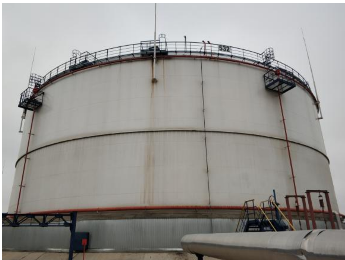
Рисунок 1 – Общий вид резервуара РВС-30000
