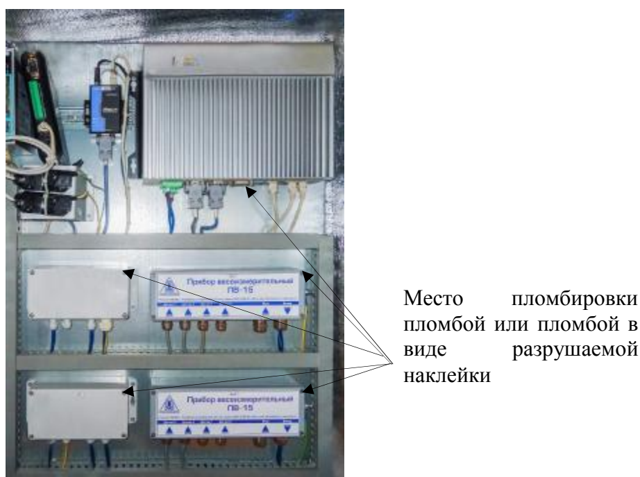
Рисунок 3 – Схема пломбировки от несанкционированного доступа
