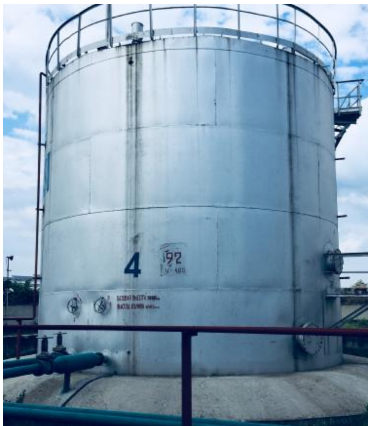
Рисунок 4 – Общий вид резервуара РВСп-400, заводской № 4
