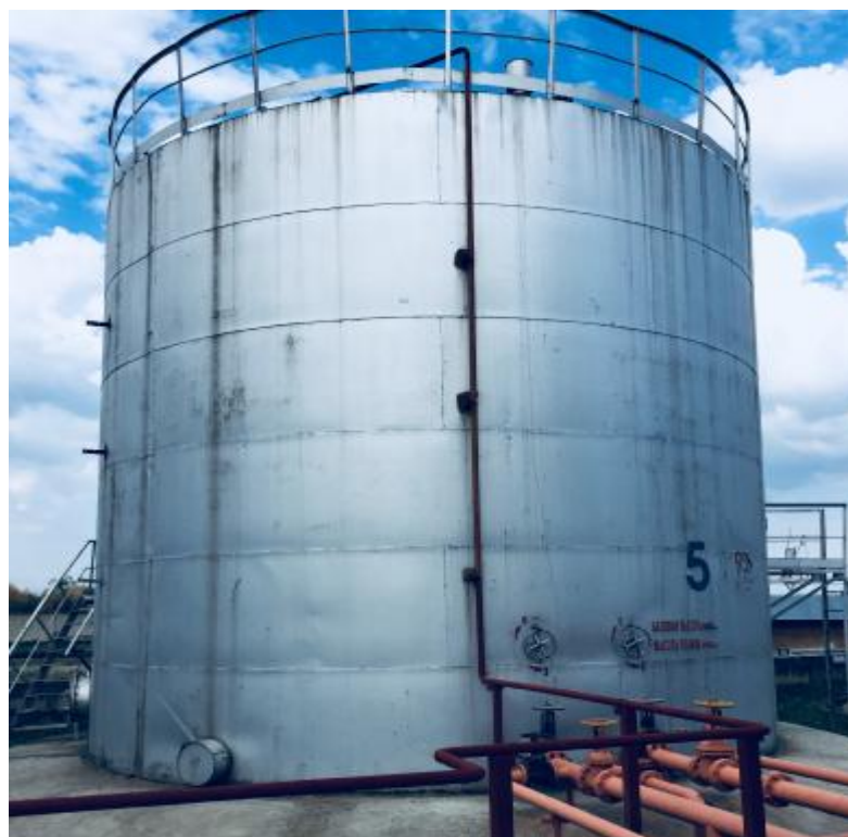
Рисунок 5 – Общий вид резервуара РВСп-400, заводской № 5
