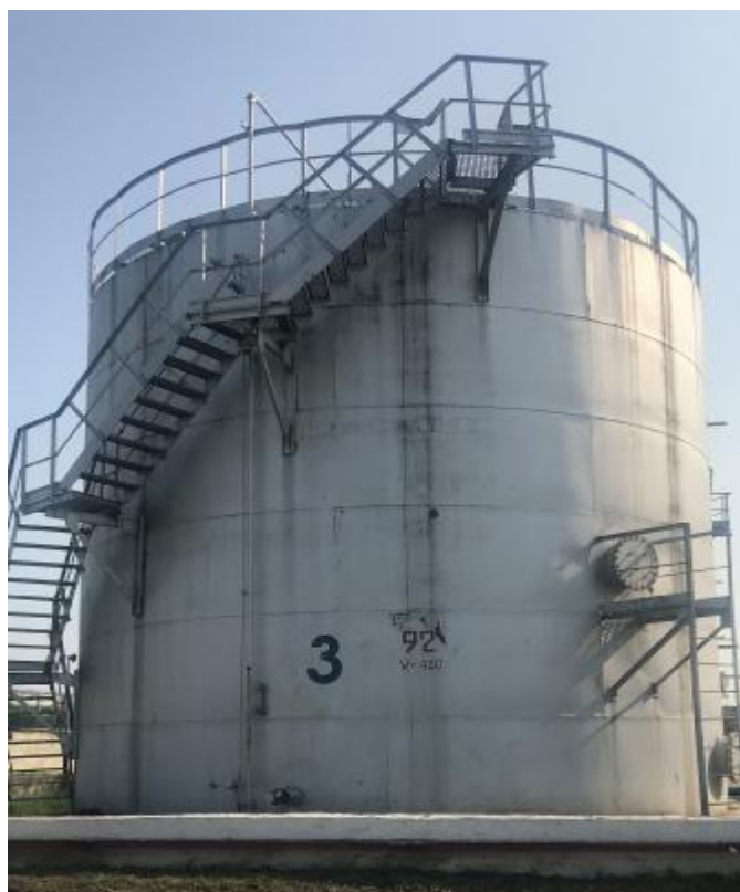
Рисунок 3 – Общий вид резервуара РВСП-400, заводской № 3
