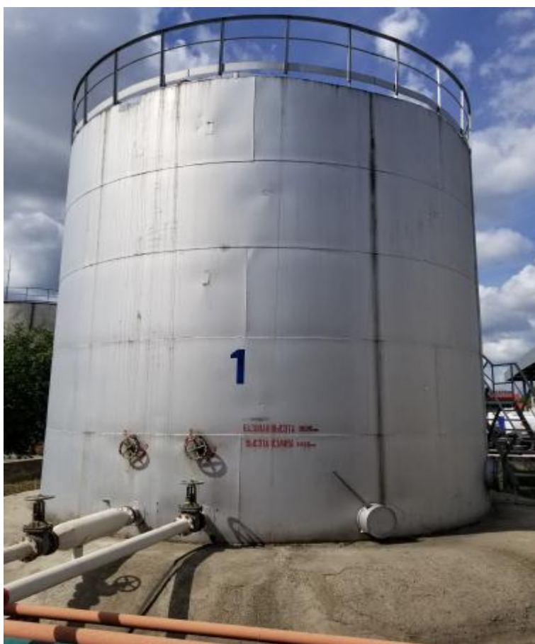
Рисунок 1 – Общий вид резервуара РВСп-400, заводской № 1
