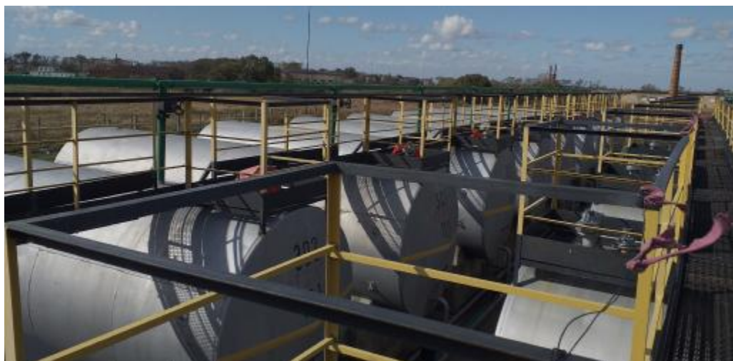
Рисунок 1 – Общий вид резервуаров стальных горизонтальных цилиндрических РГС-50
