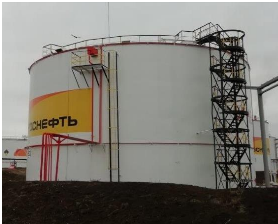
Рисунок 6 – Общий вид резервуаров стальных вертикальных цилиндрических РВСП-5000
