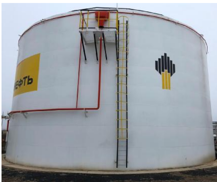
Рисунок 5 – Общий вид резервуаров стальных вертикальных цилиндрических РВС-5000
