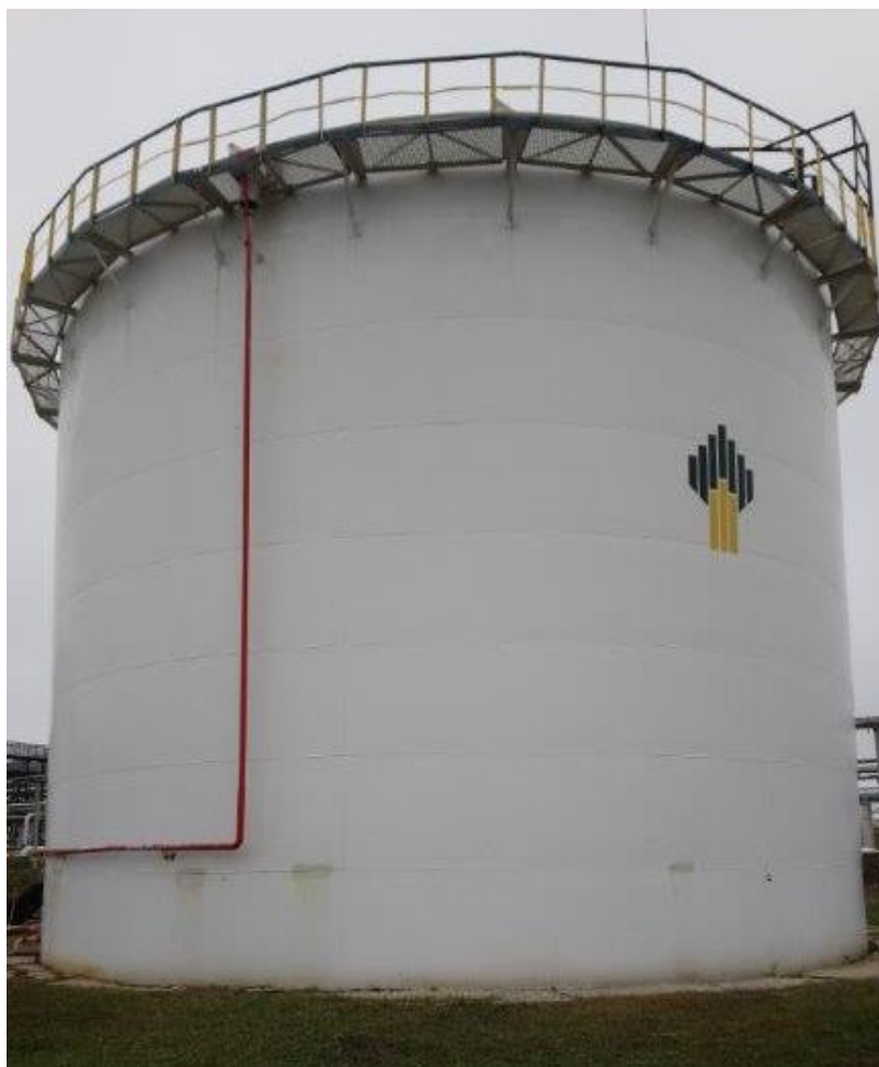
Рисунок 2 – Общий вид резервуаров стальных вертикальных цилиндрических РВС-2000
