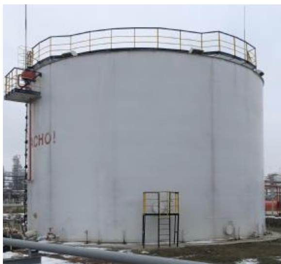
Рисунок 6 – Общий вид резервуаров стальных вертикальных цилиндрических РВСП-3000
