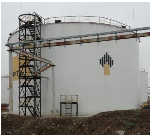
Рисунок 8 – Общий вид резервуаров стальных вертикальных цилиндрических РВСП-5000
