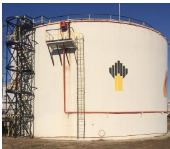
Рисунок 7 – Общий вид резервуаров стальных вертикальных цилиндрических РВС-5000
