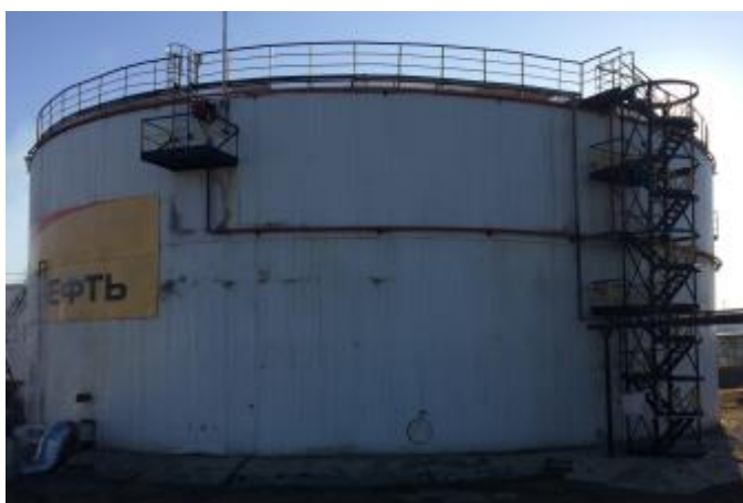
Рисунок 10 – Общий вид резервуаров стальных вертикальных цилиндрических РВС-10000
