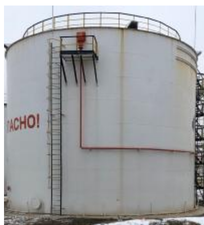
Рисунок 4 – Общий вид резервуаров стальных вертикальных цилиндрических РВСП-2000
