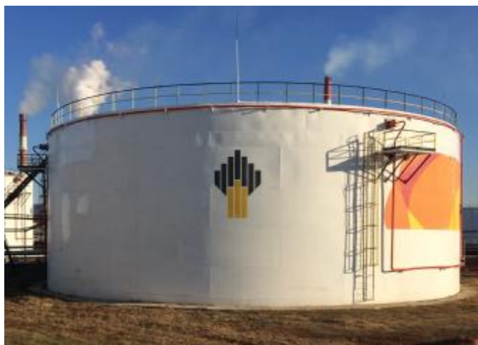
Рисунок 9 – Общий вид резервуаров стальных вертикальных цилиндрических РВС-8000
