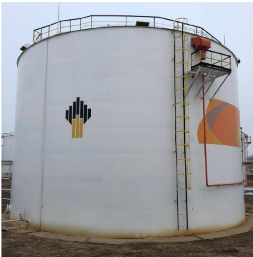
Рисунок 2 – Общий вид резервуара стального вертикального цилиндрического РВСП-3000
