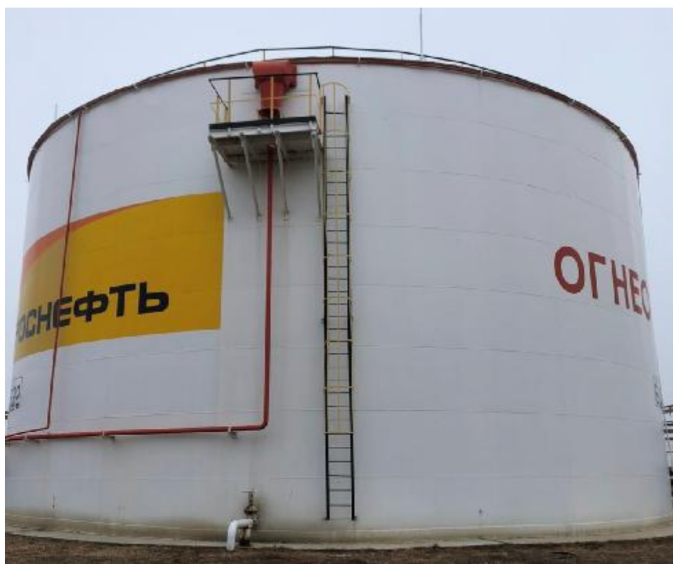
Рисунок 3 – Общий вид резервуара стального вертикального цилиндрического РВС-5000
