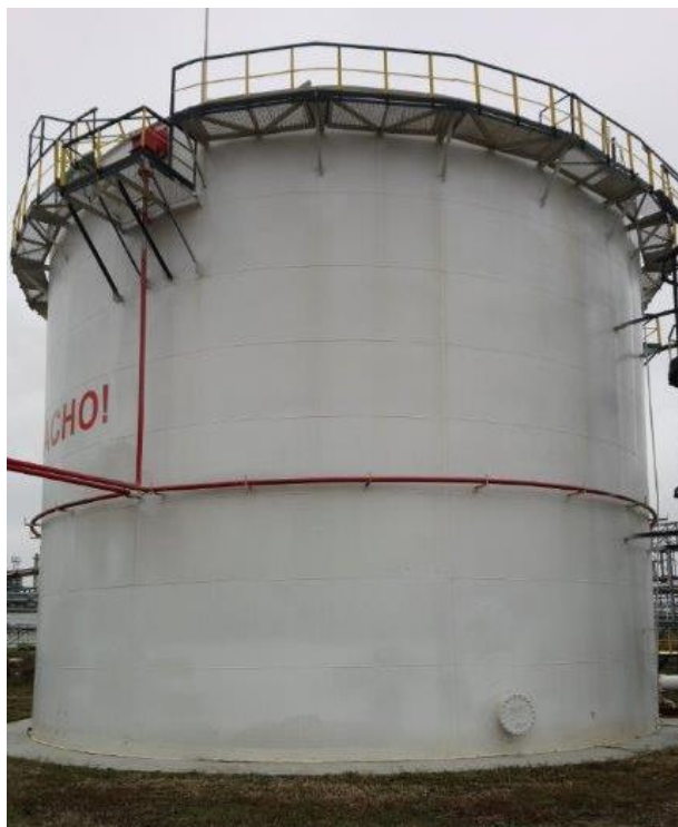
Рисунок 1 – Общий вид резервуаров стальных вертикальных цилиндрических РВС-2000
