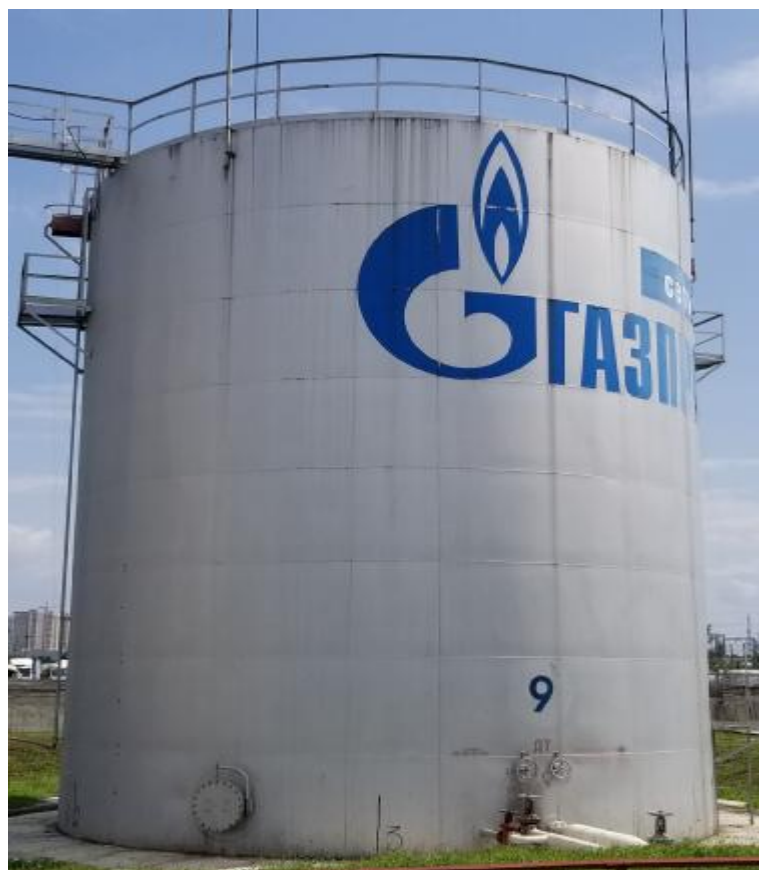
Рисунок 3 – Общий вид резервуара РВС-1000, заводской № 9
