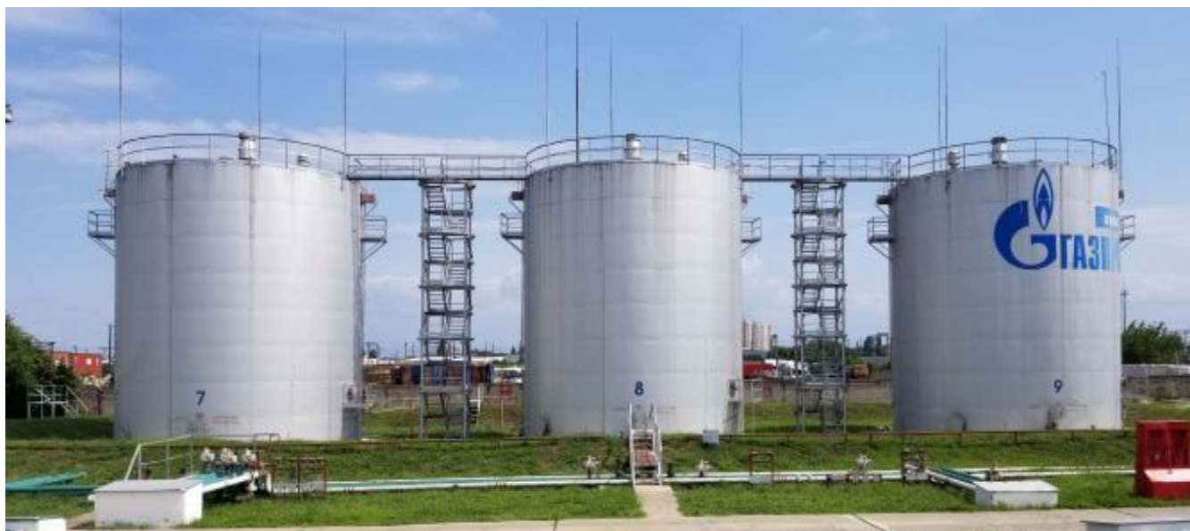
Рисунок 4 – Общий вид резервуаров РВС-1000, заводские №№ 7, 8, 9
