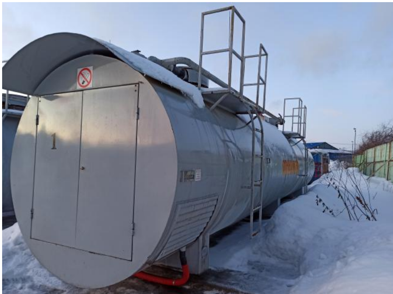
Рисунок 1 – Общий вид резервуар Р-30
