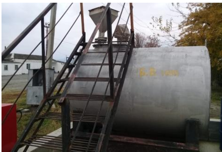
Рисунок 1 – Общий вид резервуара стального горизонтального цилиндрического РГС-3
