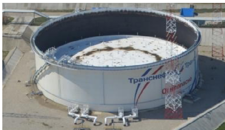
Рисунок 1 – Общий вид резервуаров РВСПК-50000 зав.№№ 1, 3
