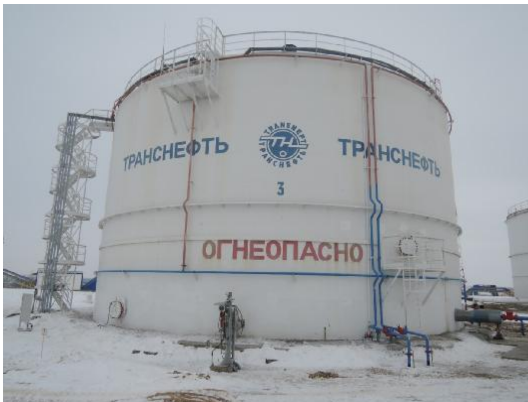
Рисунок 3 – Общий вид резервуара РВСП-5000 зав.№ 3
