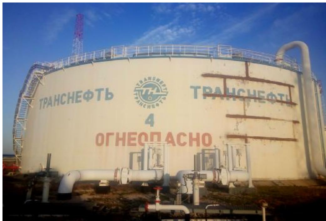
Рисунок 1 – Общий вид резервуара РВС-20000 зав.№ 4
