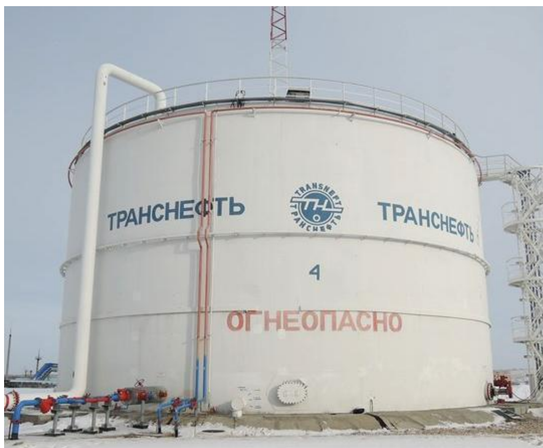
Рисунок 2 – Общий вид резервуара РВС-5000 зав.№ 4
