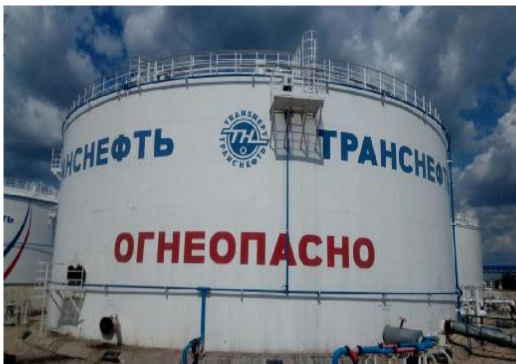
Рисунок 4 – Общий вид резервуаров РВСП-10000 зав.№№ 9, 25, 29
