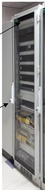
Рисунок 17 – Места расположения знаков утверждения типа и поверки и запираания стойки приборной АИИС
