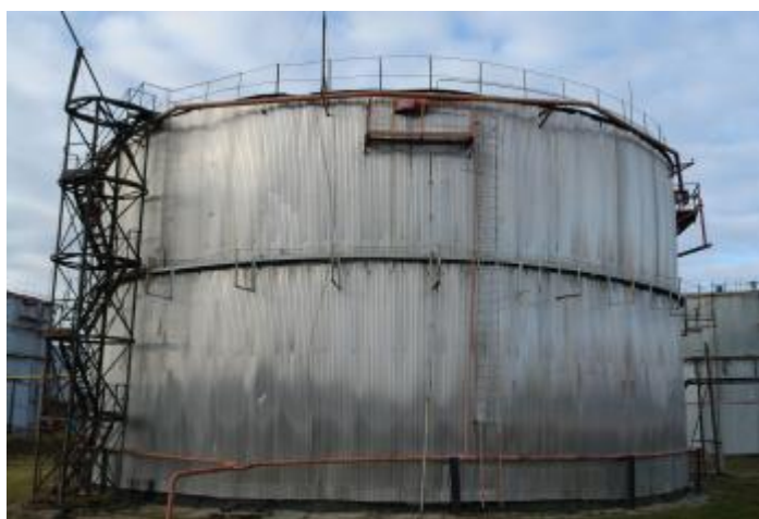
Рисунок 4 – Общий вид резервуара стального вертикального цилиндрического РВС-5000 зав.№ 9
