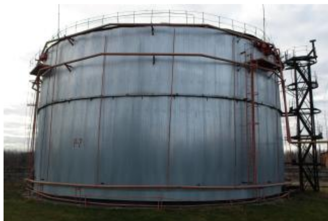
Рисунок 2 – Общий вид резервуара стального вертикального цилиндрического РВС-5000 зав.№ 7
