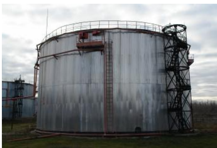
Рисунок 5 – Общий вид резервуара стального вертикального цилиндрического РВС-5000 зав.№ 12
