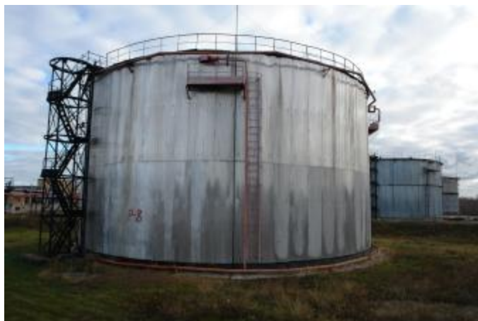
Рисунок 3 – Общий вид резервуара стального вертикального цилиндрического РВС-5000 зав.№ 8
