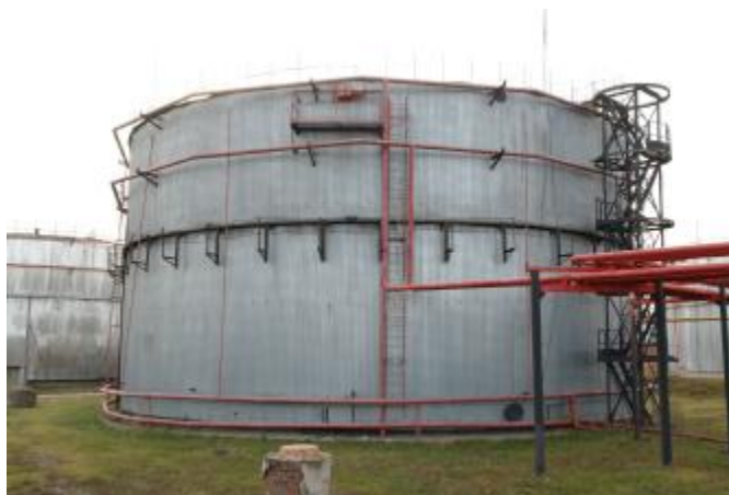
Рисунок 1 – Общий вид резервуара стального вертикального цилиндрического РВС-5000 зав.№ 6
