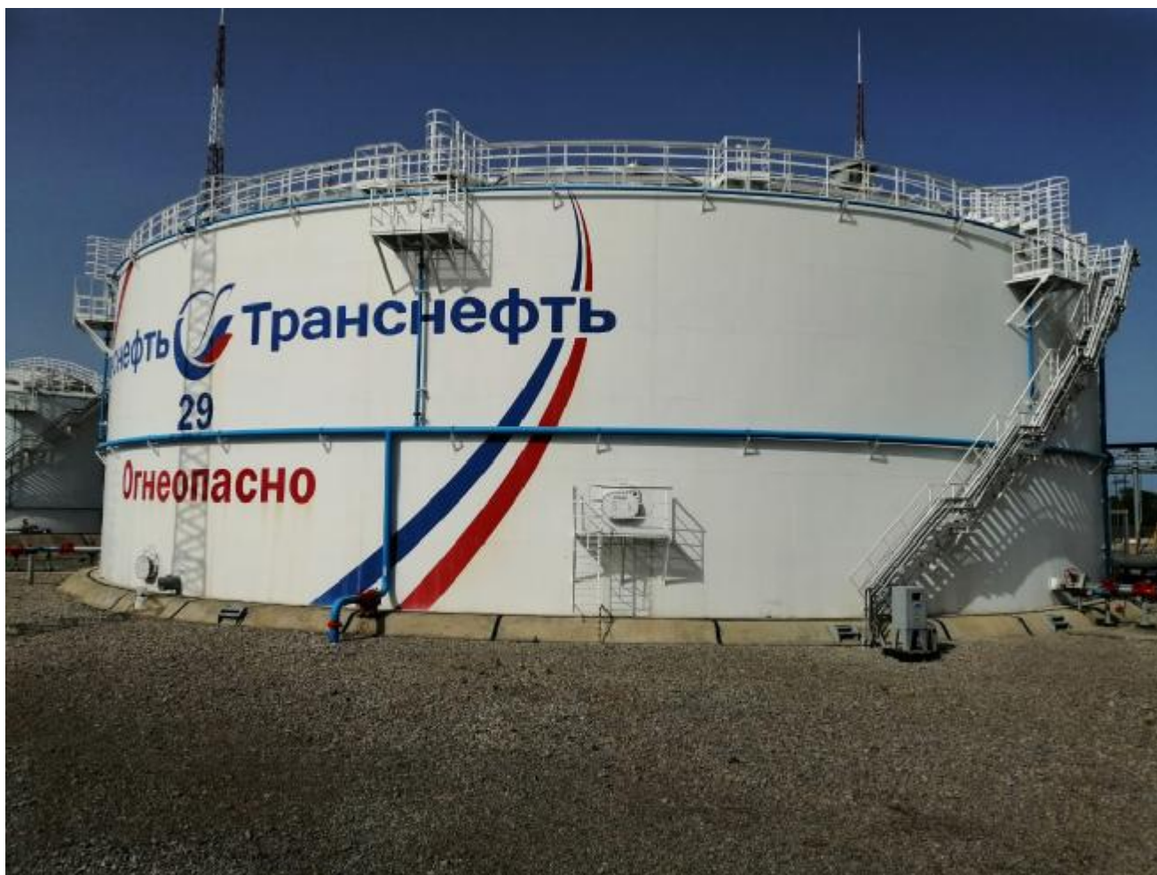
Рисунок 1 - Общий вид резервуара
