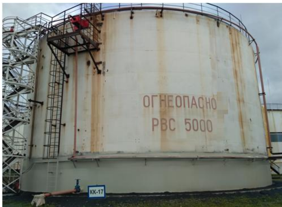
Рисунок 1 – Общий вид резервуара
