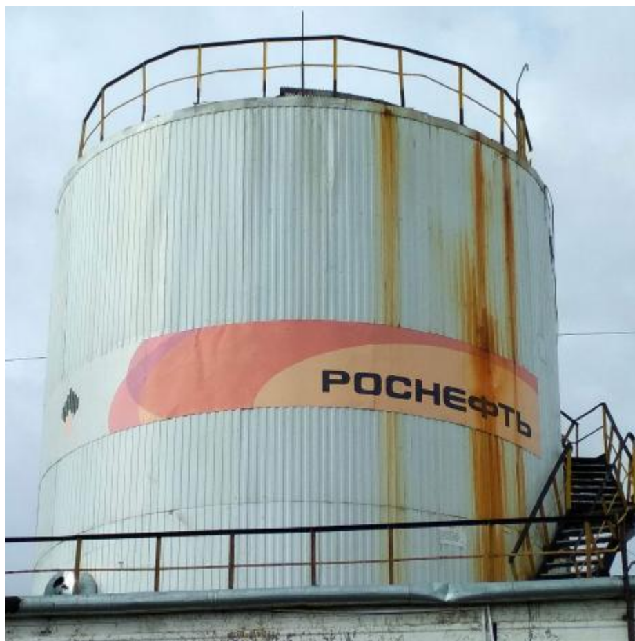
Рисунок 1 – Общий вид резервуаров стальных вертикальных цилиндрических РВС-300
