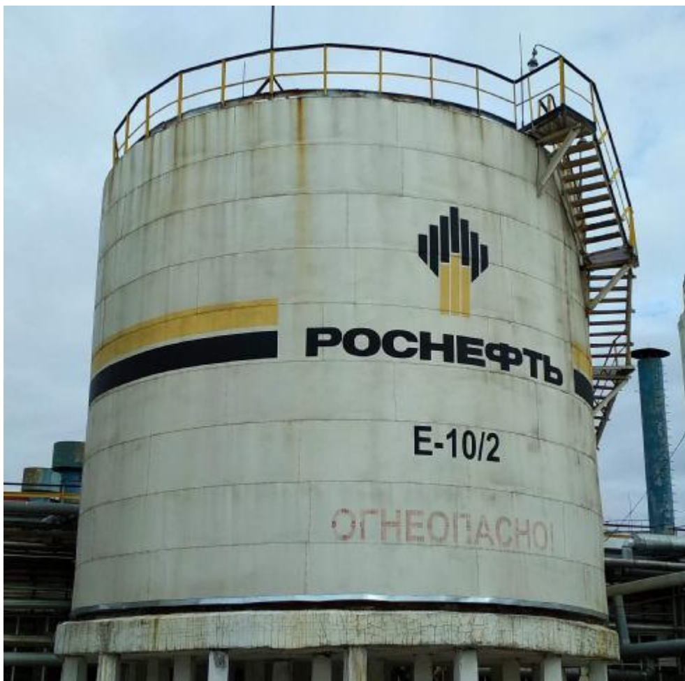
Рисунок 2 – Общий вид резервуаров стальных вертикальных цилиндрических РВС-700
