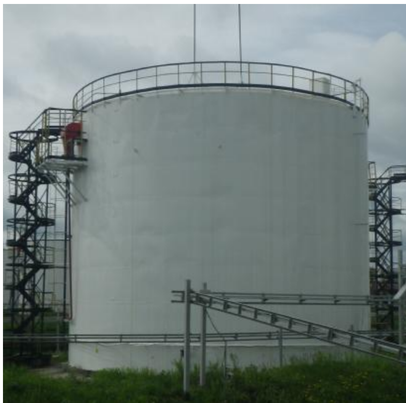
Рисунок 2 – Общий вид резервуаров стальных вертикальных цилиндрических РВС-2000
