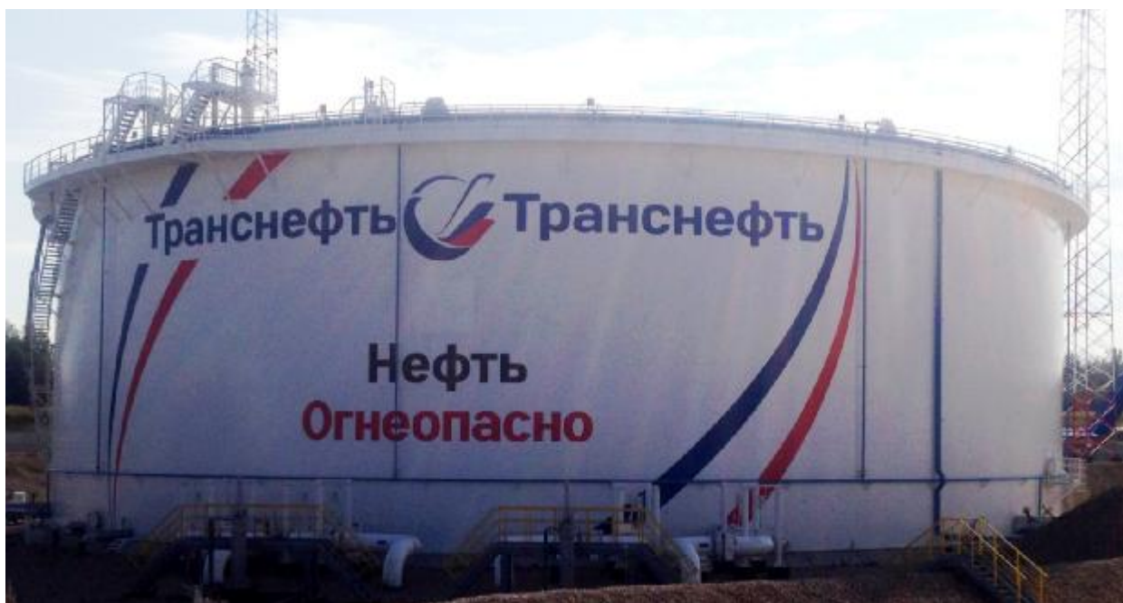
Рисунок 1 – Общий вид резервуаров РВСПК-50000 зав.№№ 9, 10, 12
