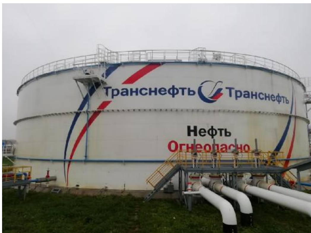
Рисунок 2 – Общий вид резервуаров РВС-20000 зав.№№ 31, 35, 40
