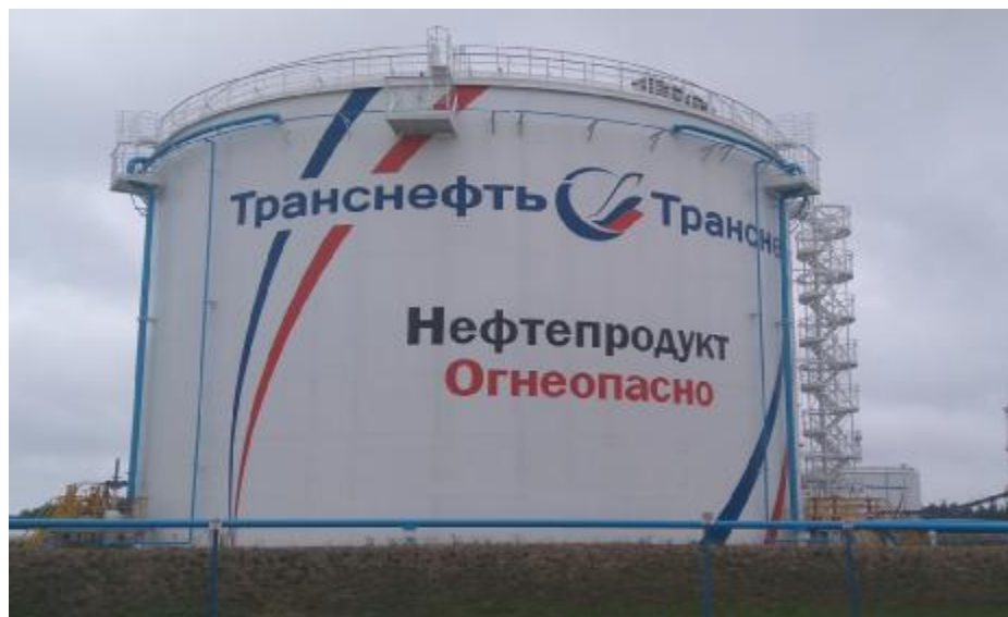
Рисунок 1 – Общий вид резервуаров РВС-10000 зав.№№ 1, 2, 3, 4, 7
