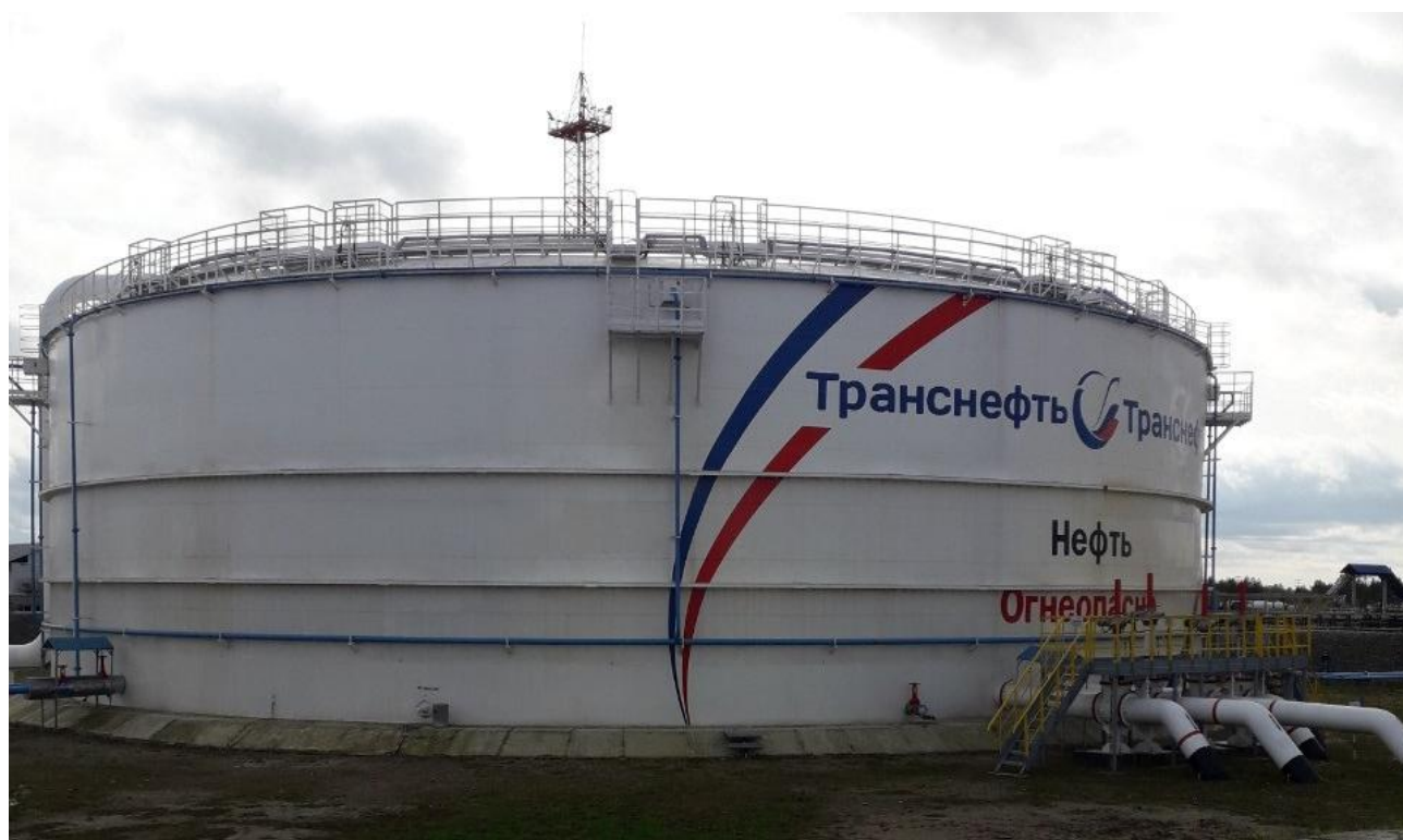
Рисунок 2 – Общий вид резервуаров РВСП-20000 зав.№№ 5, 6
