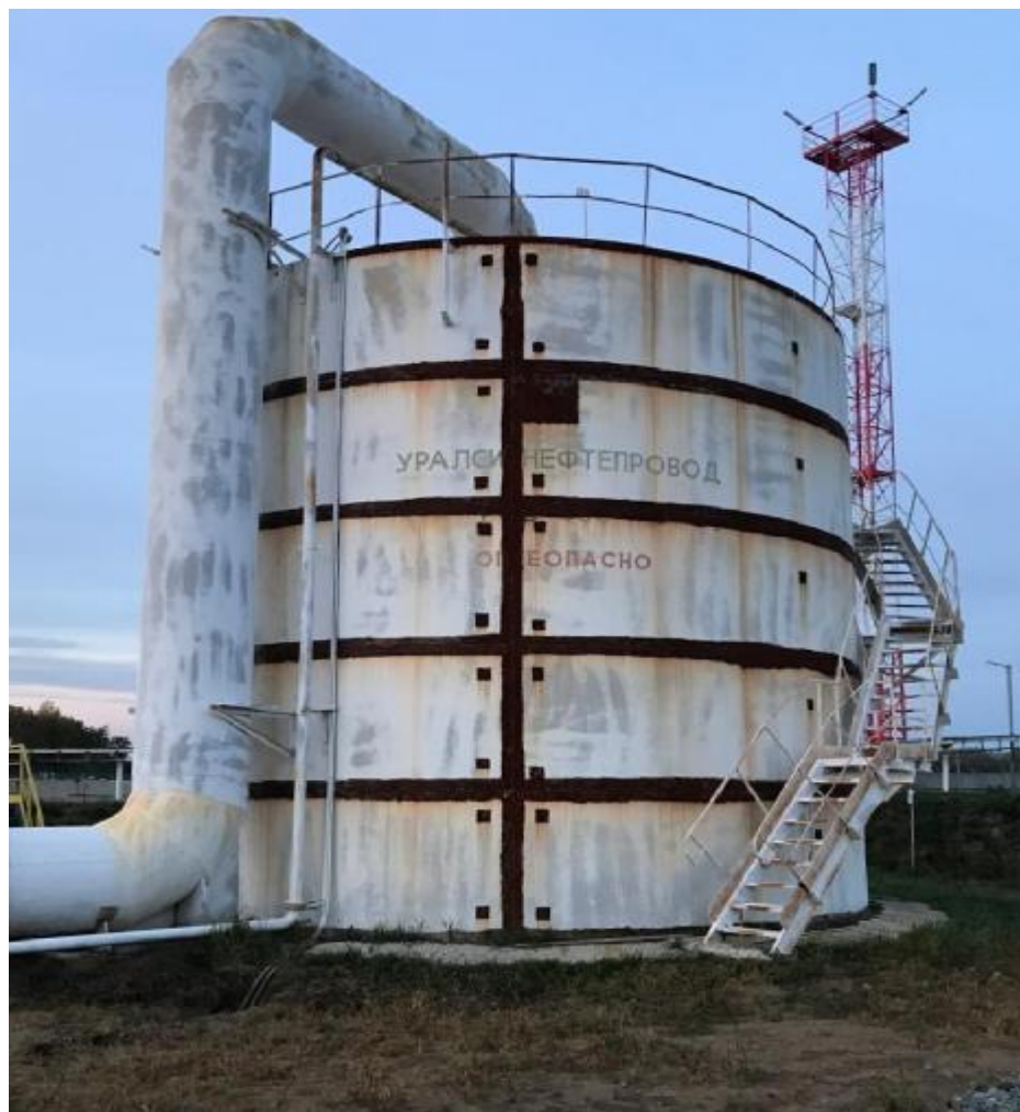
Рисунок 1 – Общий вид резервуаров РВС-400 зав.№№ 11, 12
