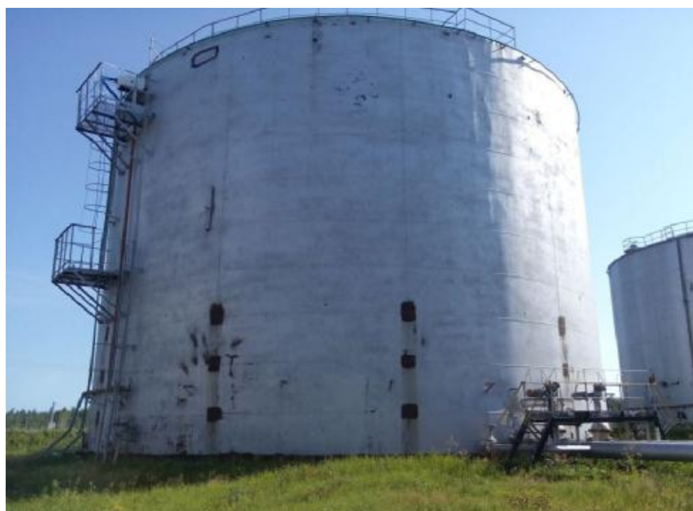
Рисунок 2 – Общий вид резервуаров РВС-5000 зав.№№ 7, 9
