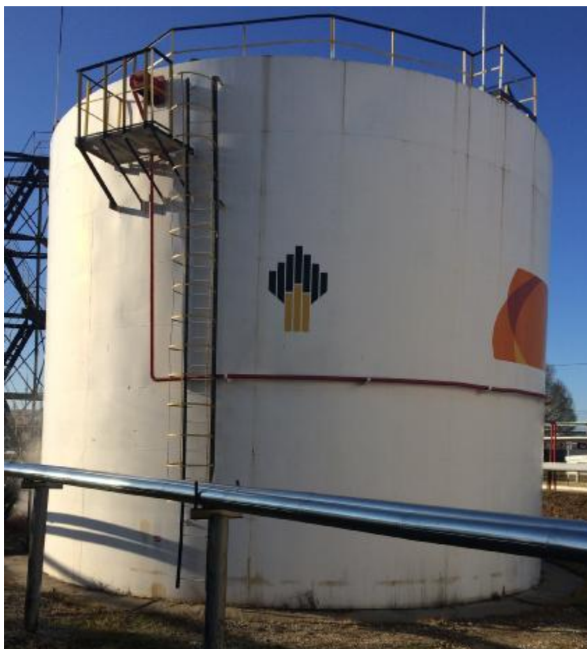
Рисунок 1 – Общий вид резервуара стального вертикального цилиндрического РВС-2000
