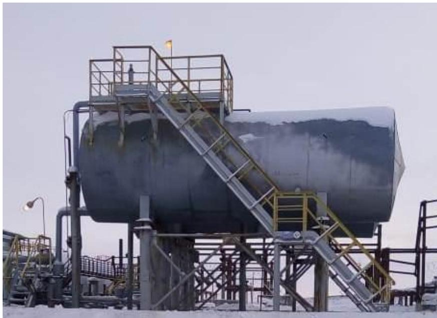
Рисунок 1 – Общий вид резервуара стального горизонтального цилиндрического РГС-75
