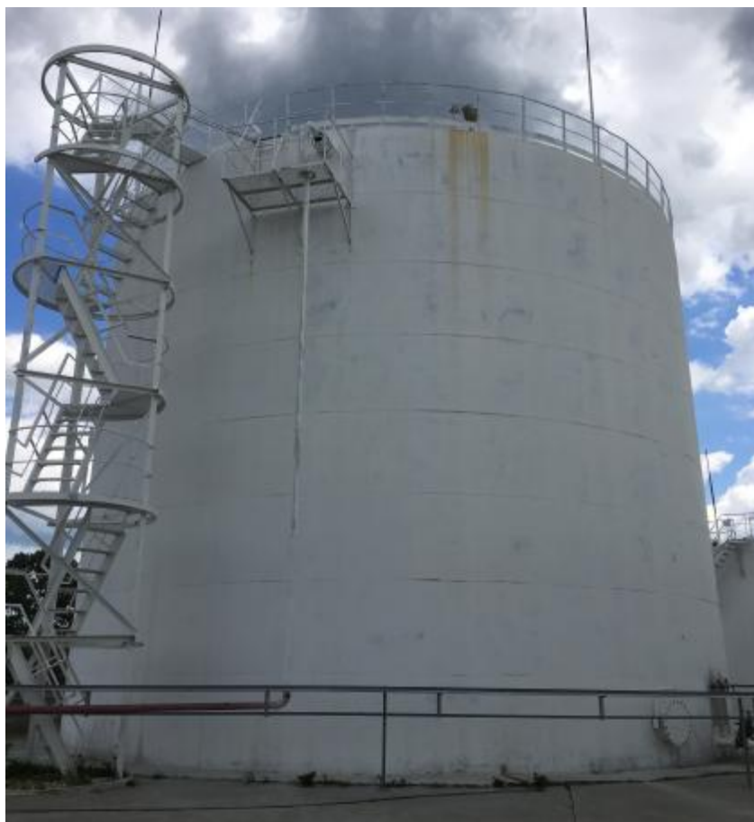
Рисунок 2 – Общий вид резервуаров стальных вертикальных цилиндрических РВС-2000
