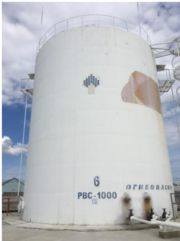
Рисунок 1 – Общий вид резервуаров стальных вертикальных цилиндрических РВС-1000
