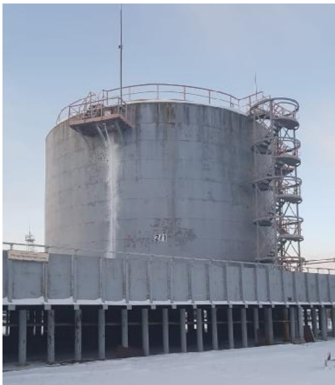
Рисунок 1 – Общий вид резервуара стального вертикального цилиндрического теплоизолированного РВС-2000
