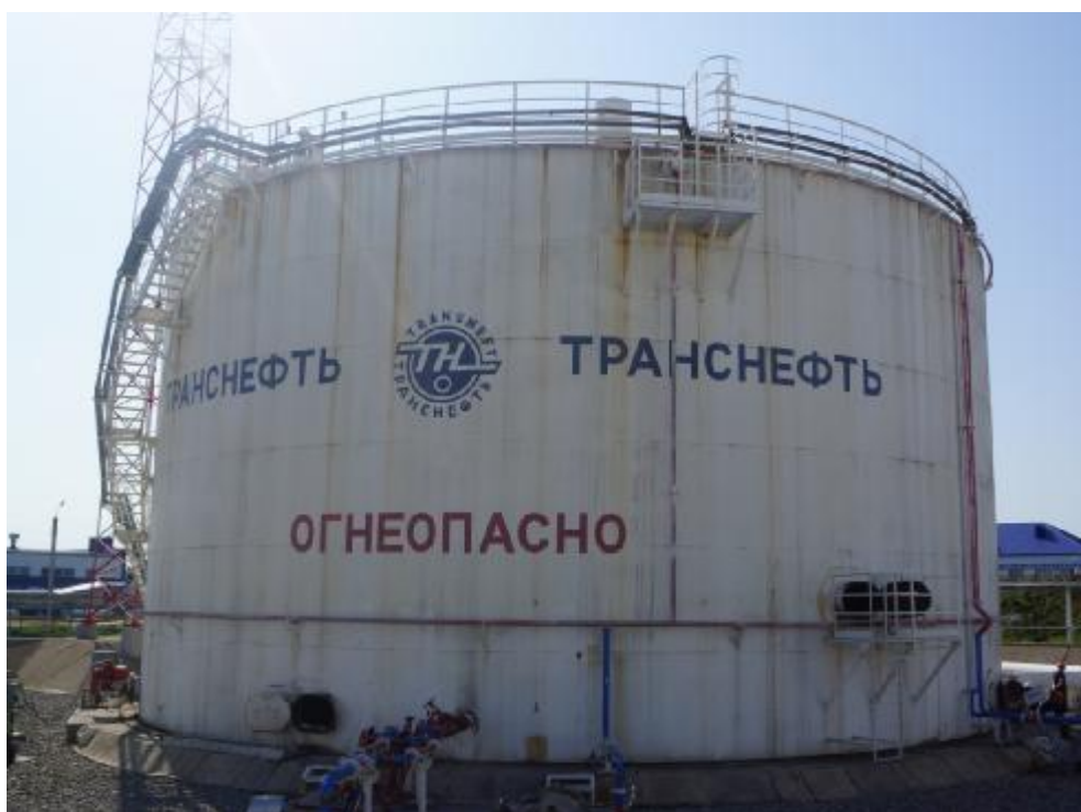
Рисунок 2 – Общий вид резервуаров РВСП-5000 зав.№№ 3, 5
