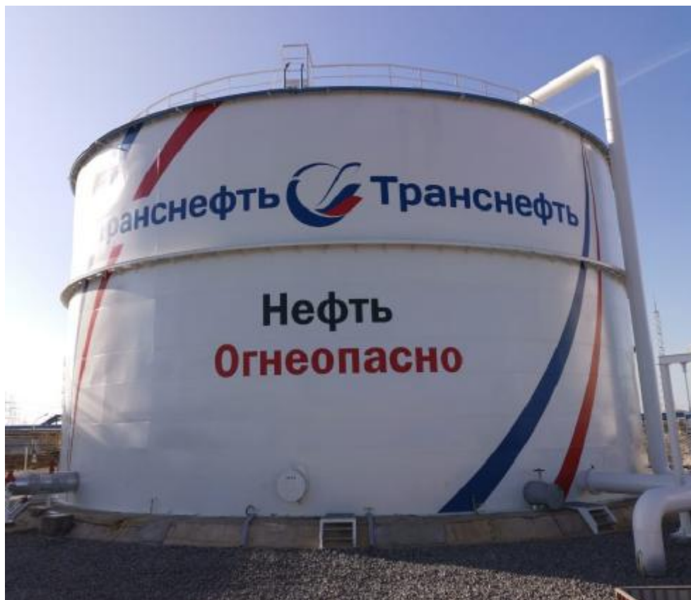
Рисунок 1 – Общий вид резервуаров РВС-5000 зав.№№ 2, 3
