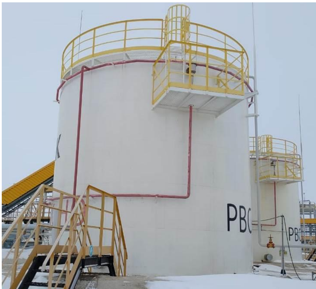
Рисунок 1 – Резервуар вертикальный стальной цилиндрический РВС-400
