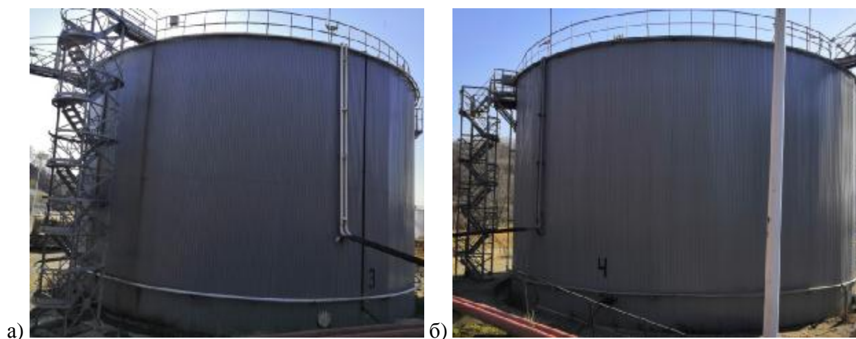
Рисунок 3 – Общий вид резервуара стального вертикального цилиндрического РВС-5000 а) заводской номер 3, б) заводской номер 4
