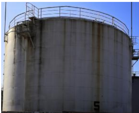
Рисунок 1 – Общий вид резервуара стального вертикального цилиндрического РВС-3000 заводской номер 5
