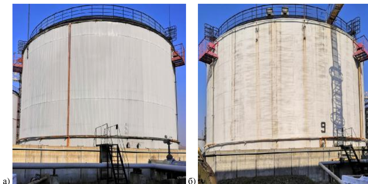
Рисунок 4 – Общий вид резервуара стального вертикального цилиндрического РВС-12000 а) заводской номер 8, б) заводской номер 9
