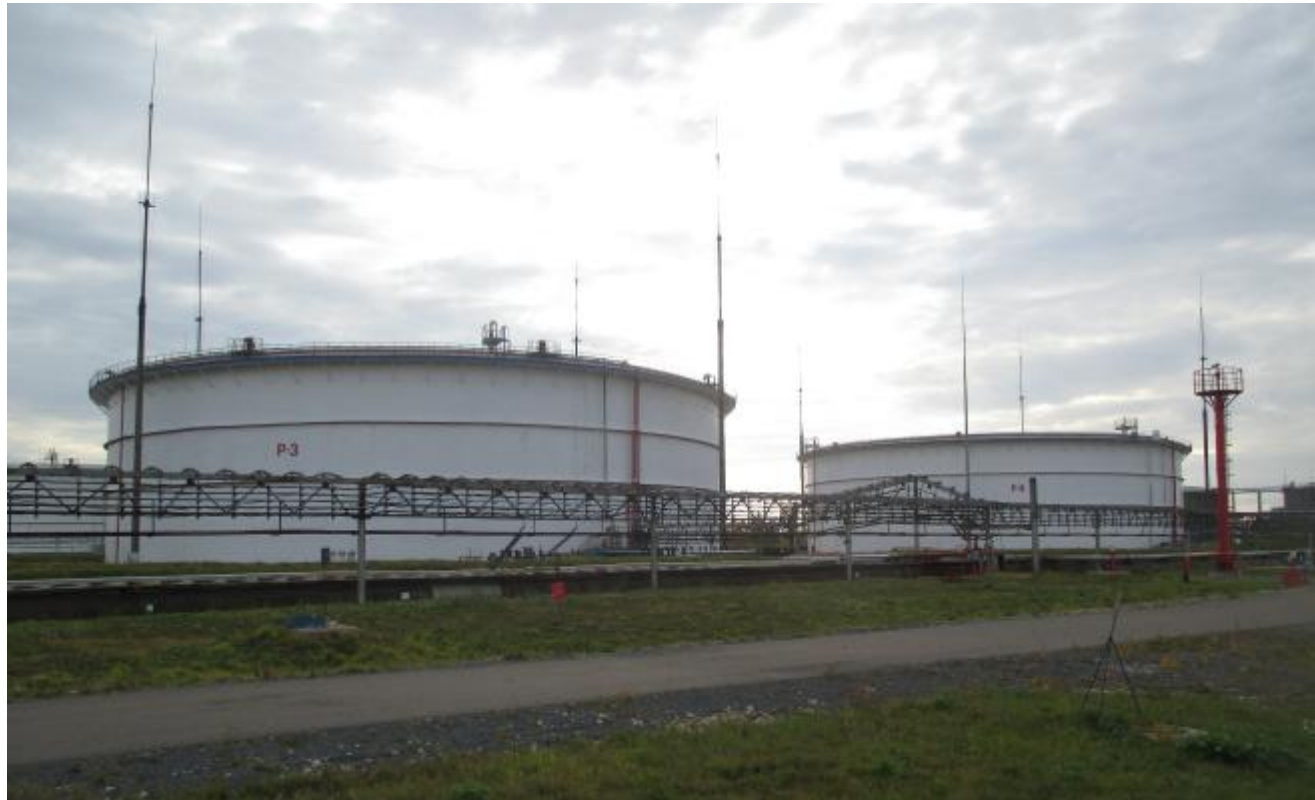
Рисунок 1 – Общий вид резервуаров стальных вертикальных цилиндрических РВСПК-50000
